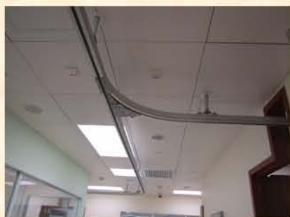
病房設天花吊機
